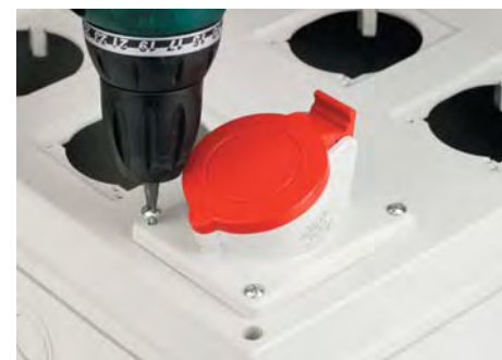
Монтаж розетки на 32 А
