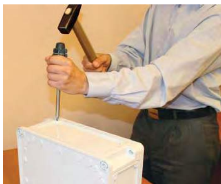
1. Удалите соединительные отверстия
