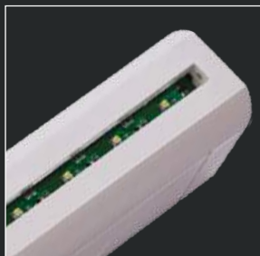
Светодиодный модуль (рассеиватель демонтирован)
